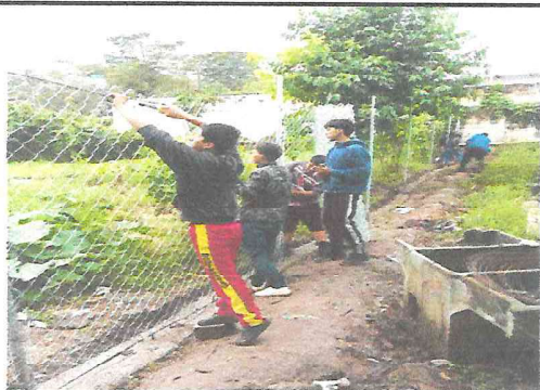
Foto 3: Cambio de estructura, tubo hg y malla
