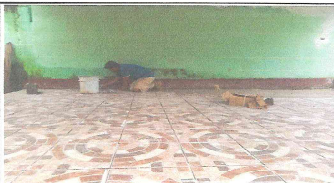
Foto 4: Cambio de piso
