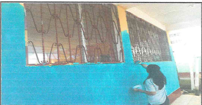
Foto 5: Pintura de paredes
